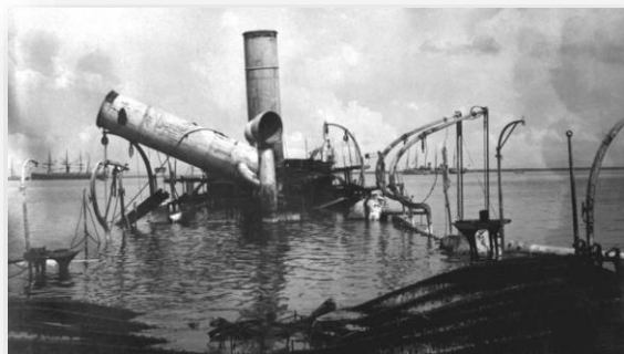
Vista del hundimiento del crucero Reina Cristina
